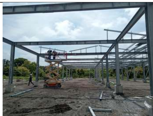
Montaje Estructura Metálica para Generador Fotovoltaico
