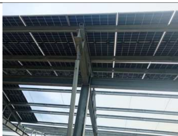
Montaje Estructura Metálica para Generador Fotovoltaico
