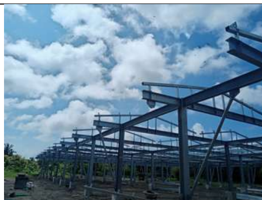
Montaje Estructura Metálica para Generador Fotovoltaico
