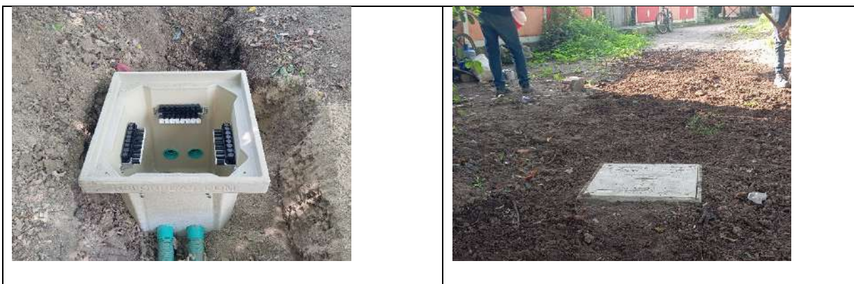
Instalación de Cajas de inspección BT
