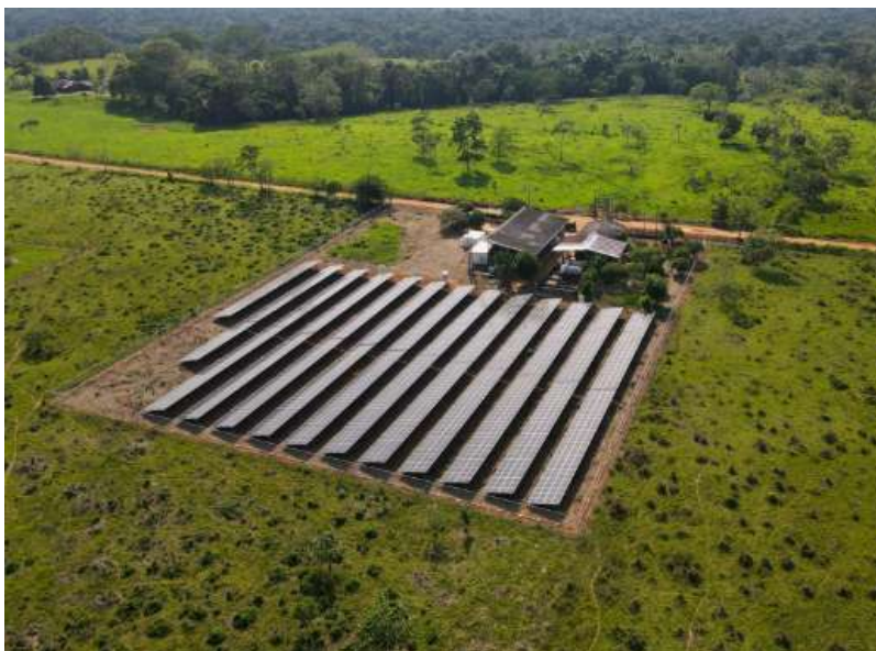
Contrato 143 de 2021 Proyecto de Mejoramiento Miraflores – San José del Guaviare SCYS
