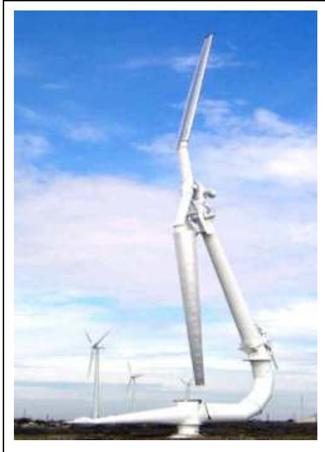
Generación Eólica (Aerogenerador Monopala)
