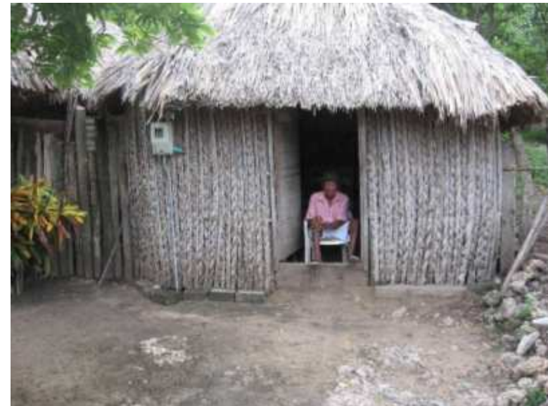
➤Detalle del sistema de medición instalado para una vivienda. Diciembre de 2008
