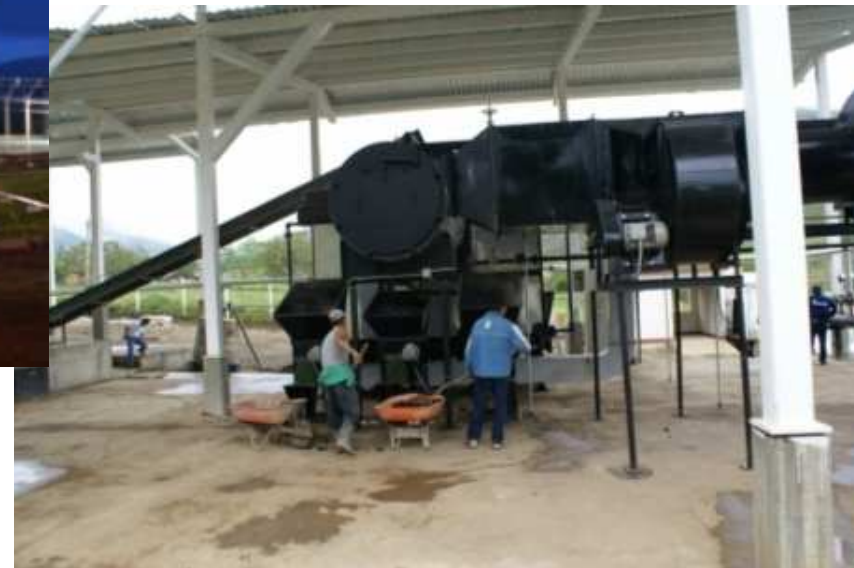
➤Detalle de trabajos en la planta de producción. Enero 2009
