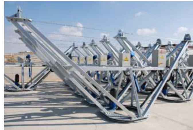
➤ Acopio de estructuras metálicas de los seguidores - España.
