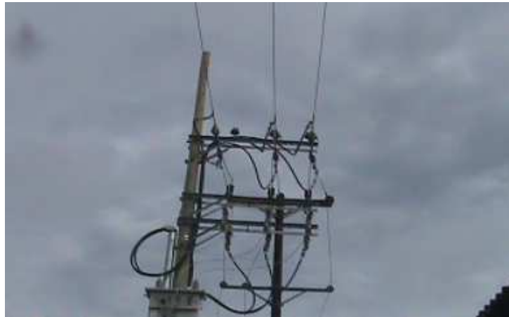
Instalación en el circuito de medida Fuente CNM
