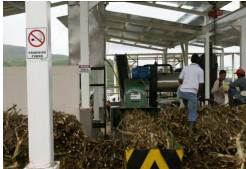
›Detalle de trabajos planta de bioetanol en Frontino – Antioquia. Diciembre de 2008.
