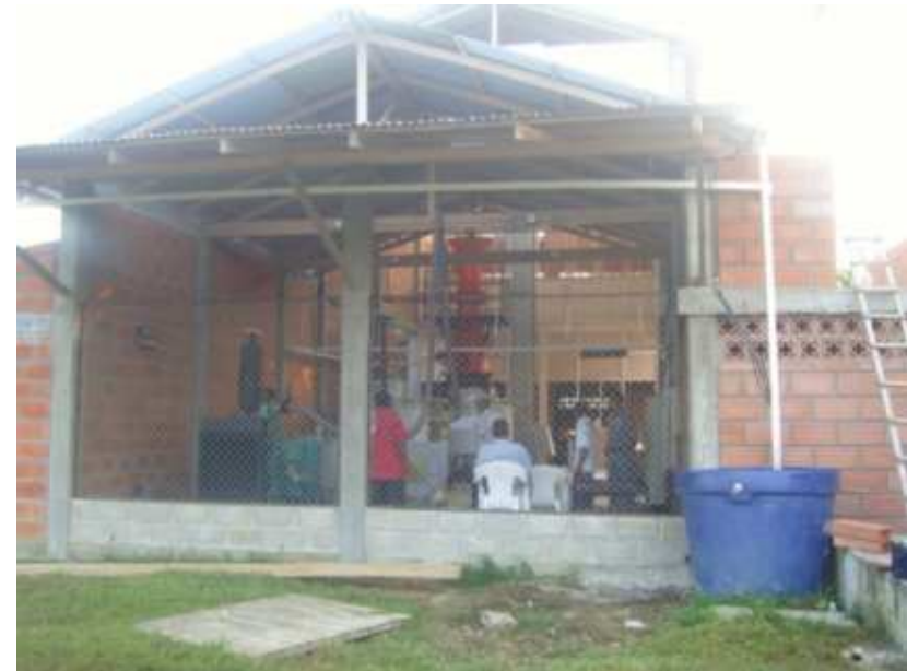
➤ Vista lateral de la casa de máquinas. Julio de 2008
