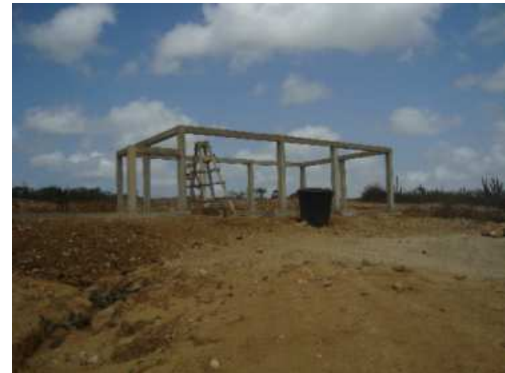
➤ Vista de la estructura de la casa de máquinas. Septiembre de 2009
