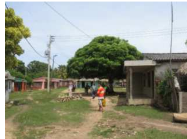
➤ Detalle de las redes aéreas de distribución en media tensión y baja tensión. Diciembre de 2008
