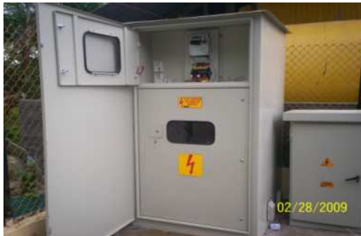
Celda de Medida y comunicaciones, vista del medidor Fuente: CNM
