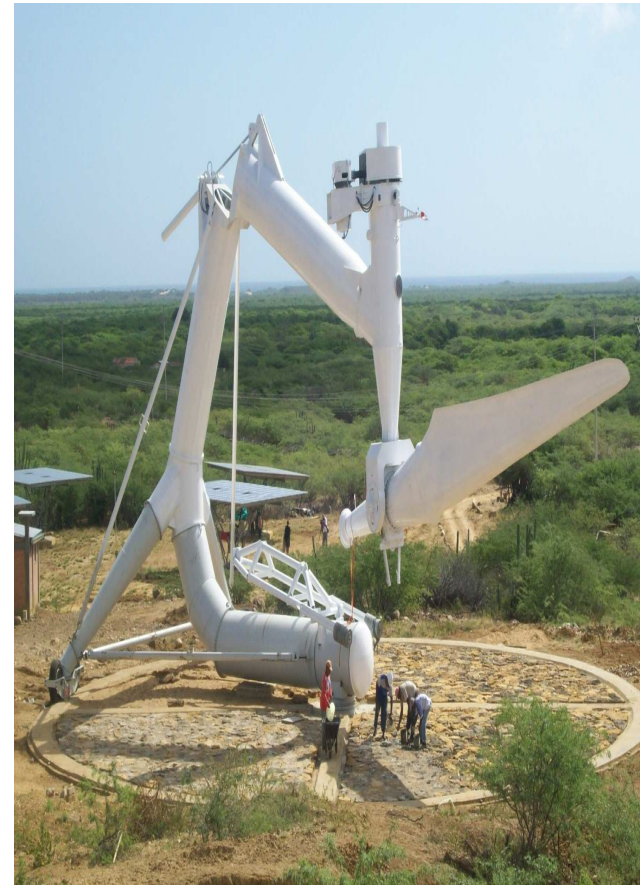
Montaje de los Aerogeneradores Fuente: IPSE, 2010
